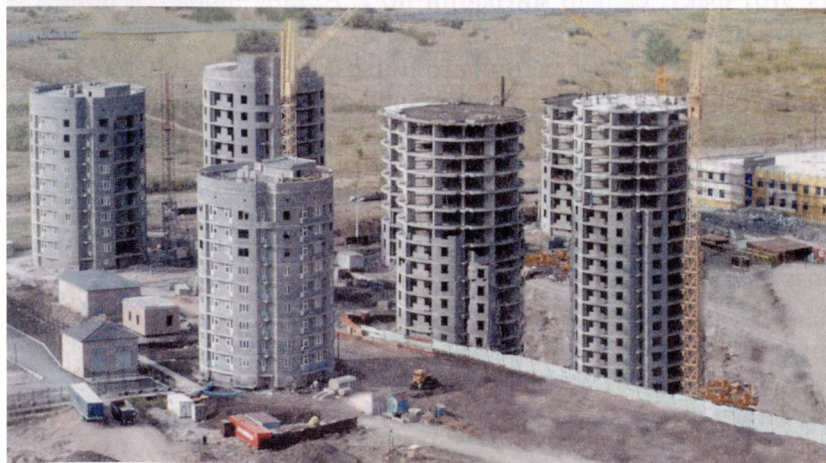
Фото 1.3. Строительство жилых домов в г. Астане
